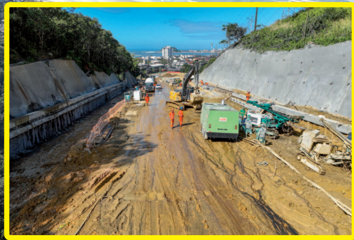
Os acessos da ponte foram projetados para garantir fluidez ao tráfego e integração com o novo sistema viário
